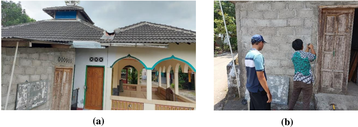
Gambar 4. (a) Pemasangan Panel Surya di atap Masjid Al Mukmin; (b) Proses instalasi box panel surya.
