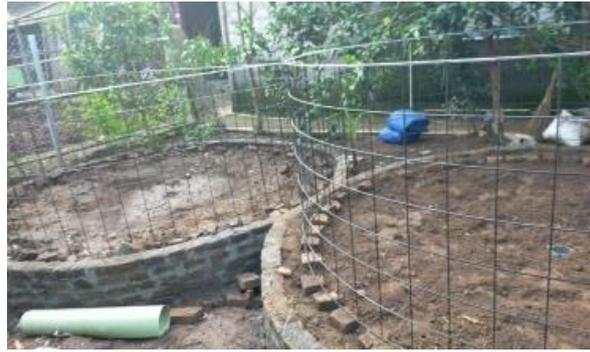
Gambar 2b. Pemasangan rangka besi kolam
