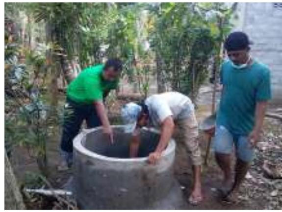
Gambar 4.b. Pembuatan bis beton lele
