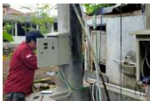
Gambar 6. Pemasangan box panel
