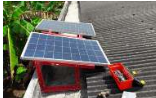
Gambar 8. Pemasangan panel surya
